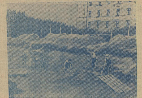
Так закладывался фундамент нового общежития.
