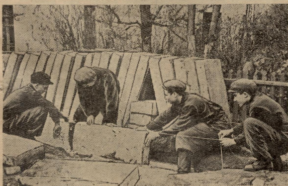
Студенты 23-й группы факультета механизации устанавливают бордюр на дороге у главного корпуса.
