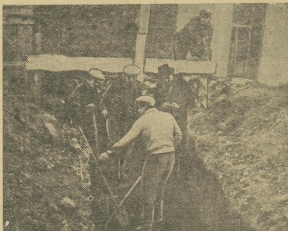
Студенты на строительстве теплосети
