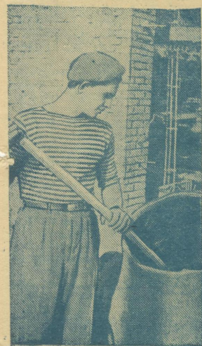
Студент 23-й группы факультета механизации Виктор Беляев работал последнее время на строительстве механической мастерской.
