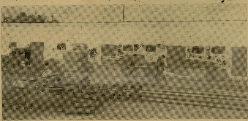
На строительстве Таврического водопровода.
