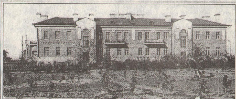
Жилой дом (Горный переулок, 4). Построен в 1915 году (подрядчик Ф.С. Корягин)
