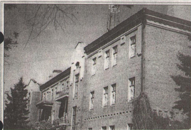
Жилой дом (Горный переулок, 2). Построен в 1915 году (подрядчик Ф.С. Корягин)
