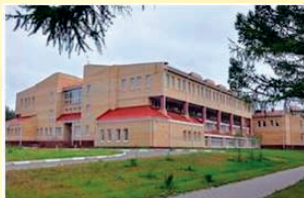
Завершено строительство здания Национальной сельскохозяйственной библиотеки.
